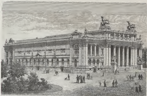
Nouveau Musée, en construction (J. J. Winders et F. Vandych).
